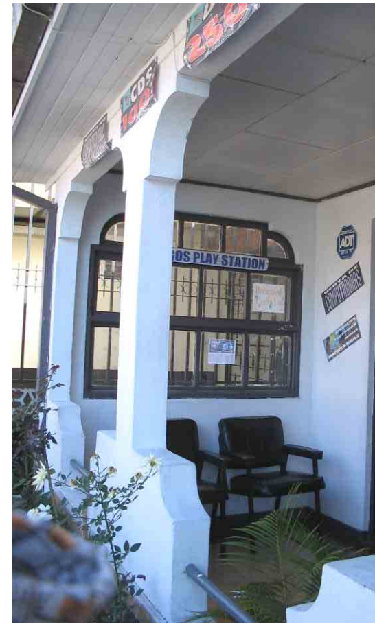
Figura 21: Detalle de columna y ventana en una vivienda en Tres Ríos Fuente: Marcela J.G.
