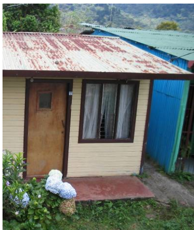
Figura 118: Piso de mosaico y lujado en corredores de viviendas en San Rafael.
