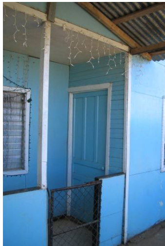
Figura 120: Vivienda mixta con presencia de tablilla y revestimiento de plywood
