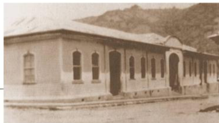
Foto de la Escuela Central de Tres Ríos luego de su reconstrucción.
