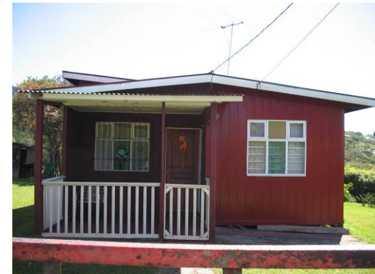
Figura 18: Ejemplo de vivienda con perfil de combinación de aguas, año 2006
