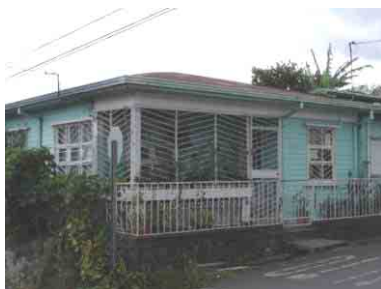
Figura 121: Columnas salomónicas, y sustitución de las columnas por rejas, distrito central
