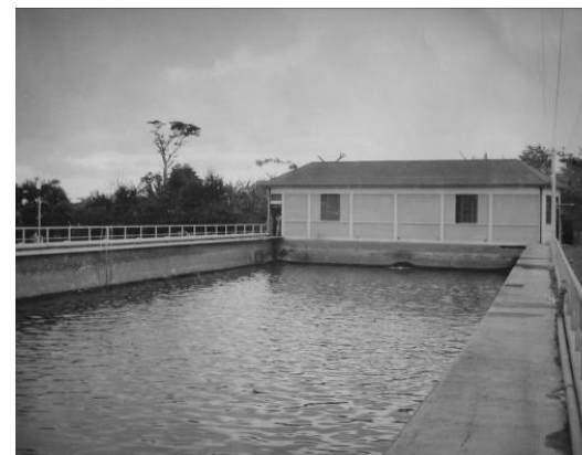
Figura 95: Vista de uno de los tanques de la Planta Alta Purificadora del agua para San José, año 1961 Fuente: Durán Aguilar, Rosa María Apuntes para una monografía sobre el cantón de La Unión . Tesis Licenciatura en Filosofía y Letras, Universidad de Costa Rica, 1961
