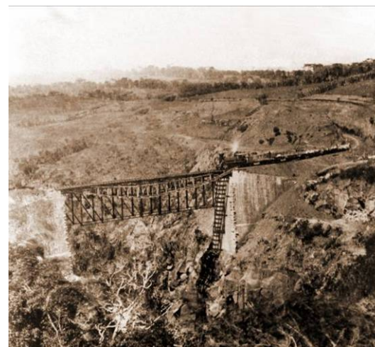
Figura 56: Puente sobre la Quebrada del Fierro, año 1873
