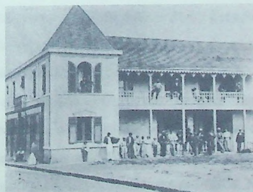
Hotel Francés, 1885, Av. 1, Calle del Carmen. Fuente: Colección de Gonzalo Montero.
